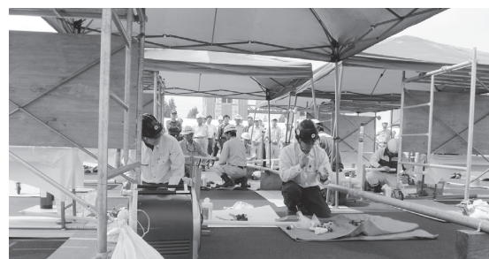
当社2名によるガス管修理訓練
